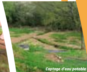
Captage d'eau potable
