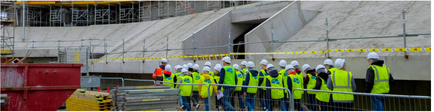
Les coulisses du bâtiment - 600 collégiens visitent le chantier Espace Mayenne
